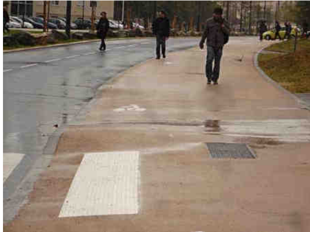
Piste au niveau du trottoir, bien située côté chaussée, mais là aussi pas de séparation.
